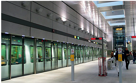
Abb 2: GridScan/LR überwacht Bahn-, Strassenbahn- und U-Bahnsteige über Distanzen bis 80 m
