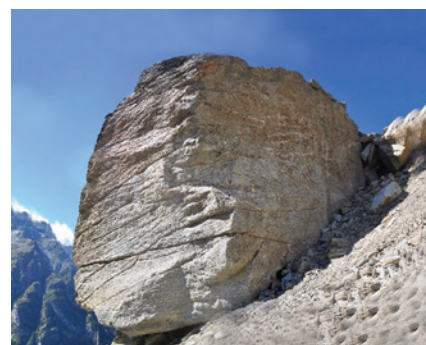
► Monitoring skalních formací nad železniční trati
