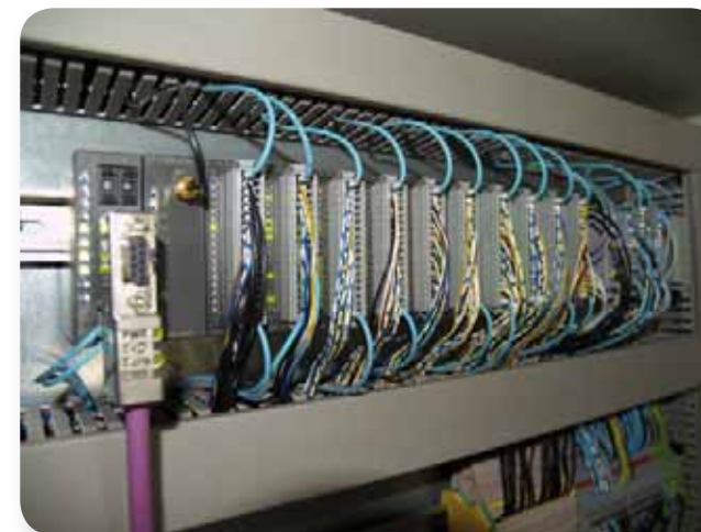
Řídicí systém VIPA 200V jako decentrální periferie je robustní a mnohostranně využitelný při automatizaci budov.
